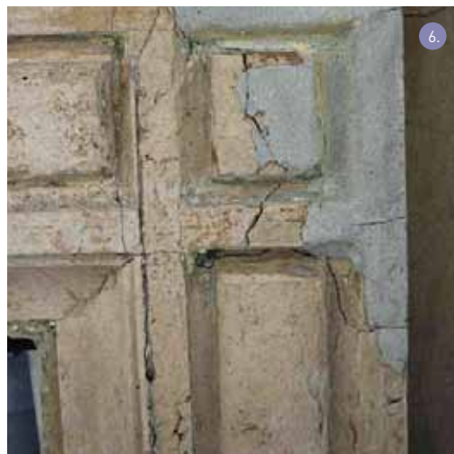
7. Detal architektoniczny uszkodzony przez agresywne oczyszczenie i pokryty nową warstwą współczesnej farby.
